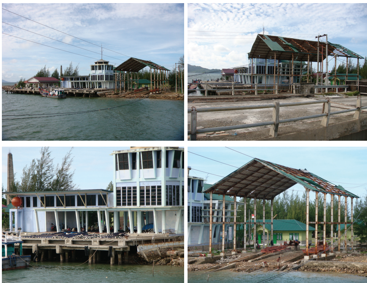
写真 1 港湾施設の老朽化
