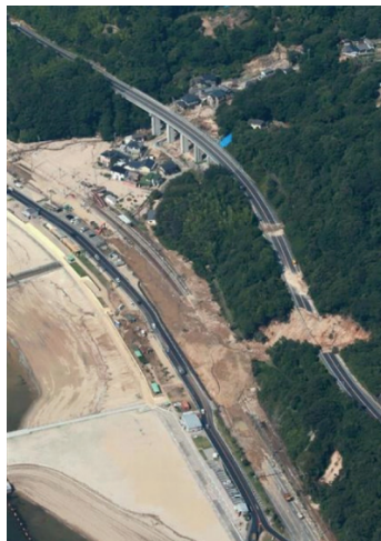
図9 寸断された坂町の広島呉道路と JR 呉線 (2018.7.12 : 産経)
