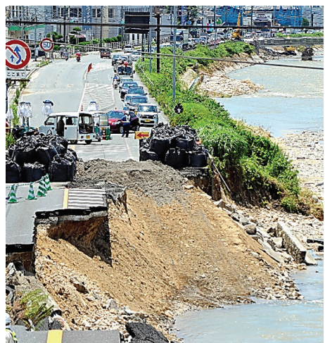
図10 広島市安芸区の国道2号の崩落 (2018.7.10 : 朝日)
